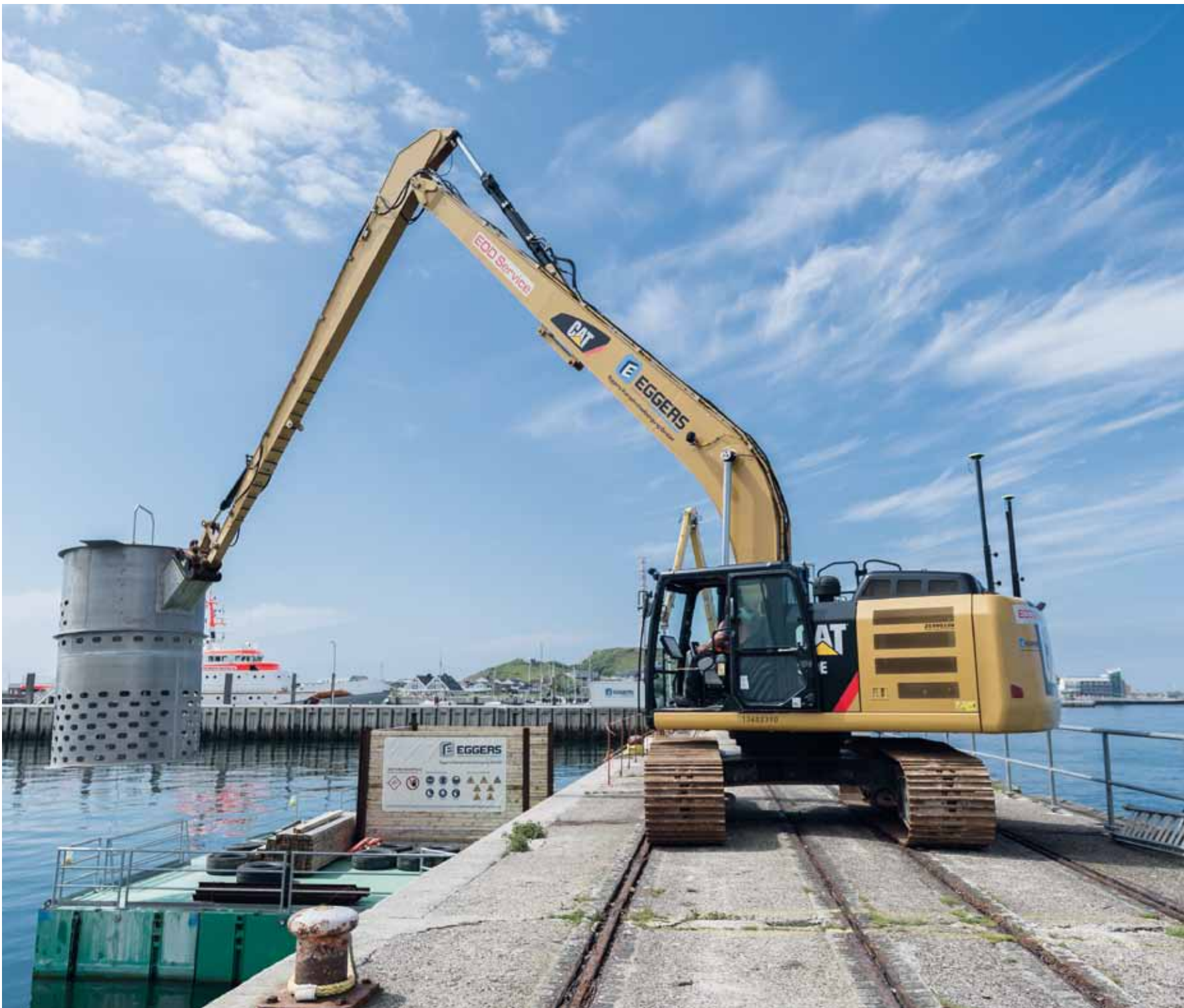
Der Bagger hebt die Strömungsglocke ins Wasser.
