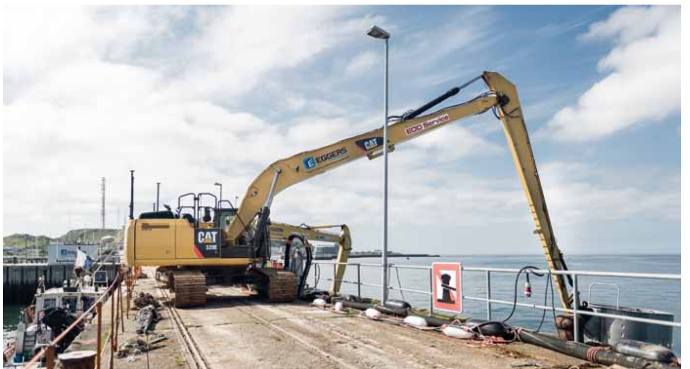
Die Baumaschine mit rund 30 Tonnen Einsatzgewicht wird von der Mole aus bewegt.
