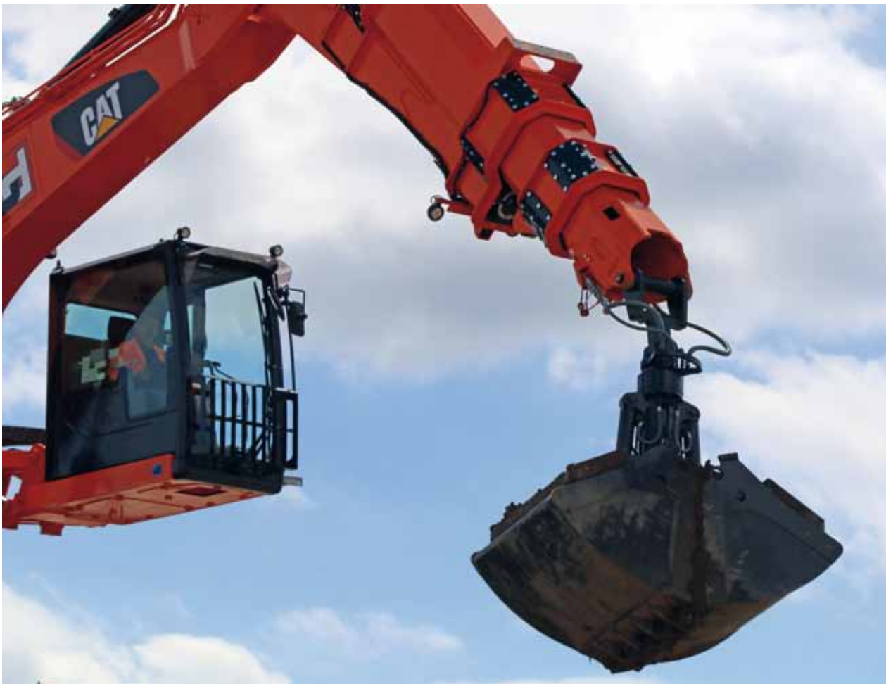
Aushub über den Wolken.
