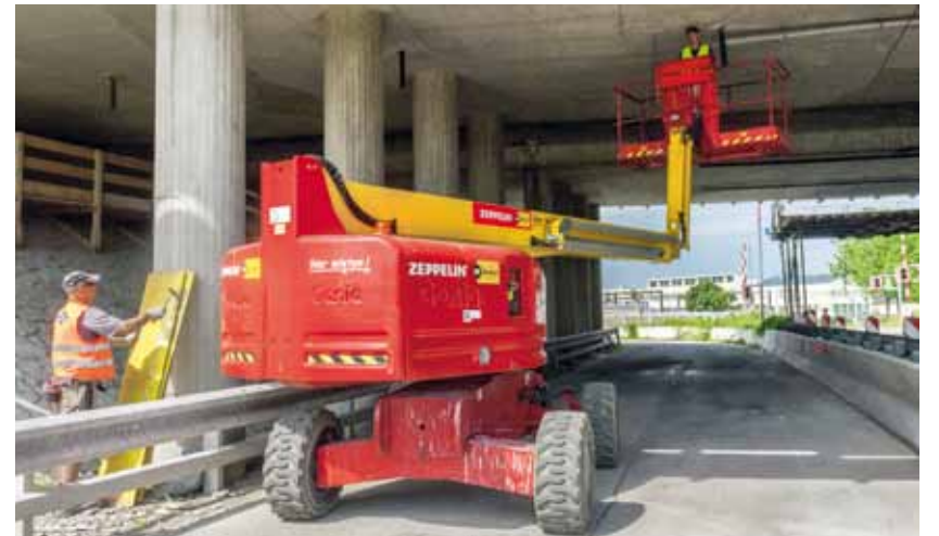
Mietgeräte wie eine Teleskoparbeitsbühne unterstützen bei der Brückensanierung auf der Ost Autobahn A4 derzeit vor allem bei Schalungsarbeiten.
