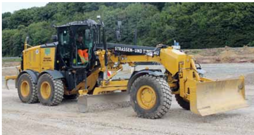
Derzeit wird mit dem Grader das Planum für einen Autobahnparkplatz an der A45 erstellt. Fotos: Zeppelin
