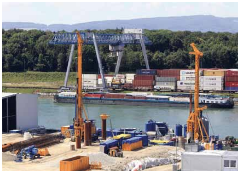
Im Zuge der Sanierung von Perimeter 1/3-NW der Altablagerung Kesslergrube starteten die Großlochbohrungen für den Bodenaustausch und die Baugrube. Foto: Roche
