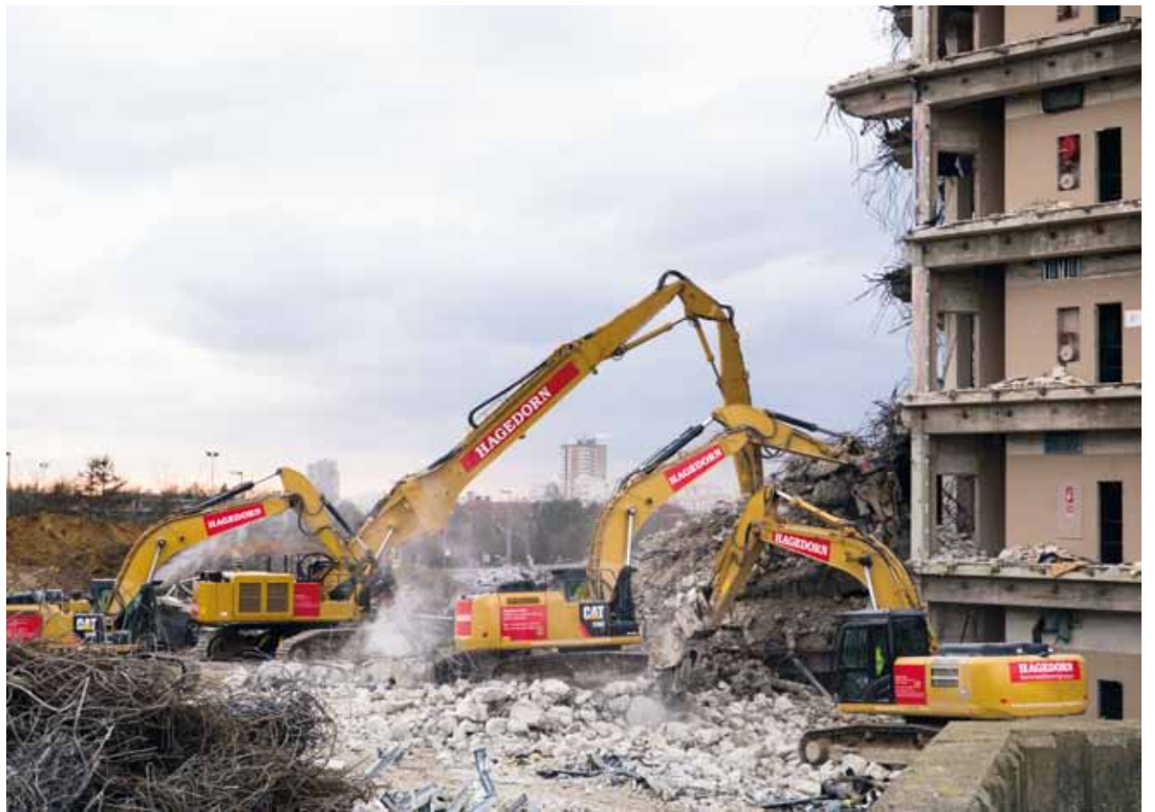
Im November 2015 rückten drei Longfrontbagger sowie sechs 40-Tonnen-Bagger mit Pulverisierern dem Rohbau zu Leibe. Fotos: Hagedorn
